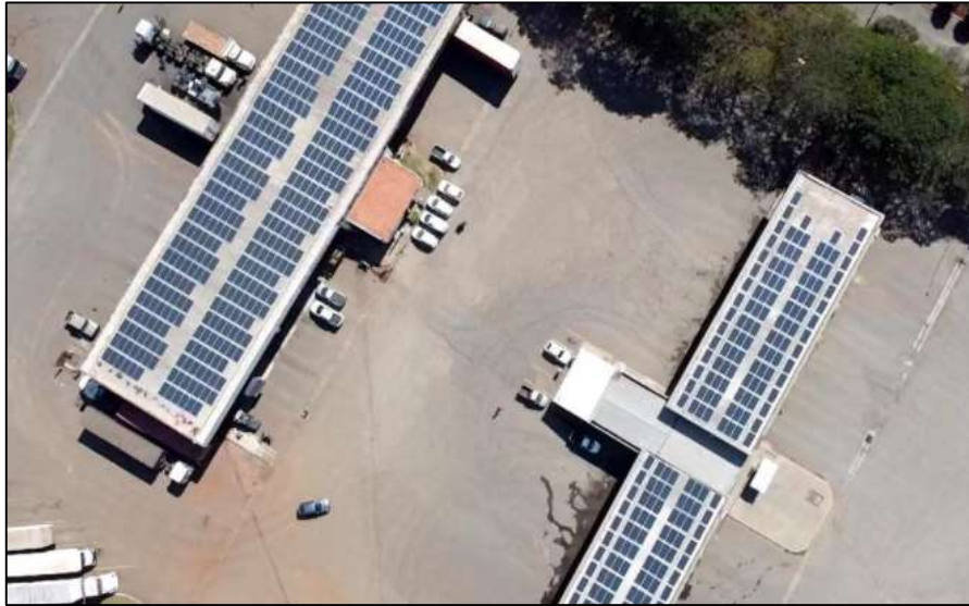
Figura 12 – Posto de Gasolina
