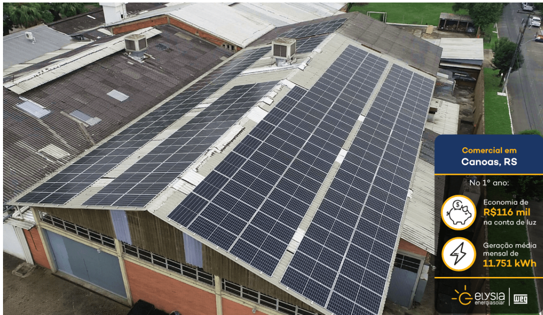
Figura 10 – Telhado solar comercial
